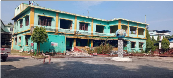
जेनजी आन्दोलनले ध्वस्त भएको दमक नगरपालिकको पुरानो प्रशासनिक भवन (उत्तरपट्टि) को संरचना भत्काउन सुरु गरिएको छ ।
