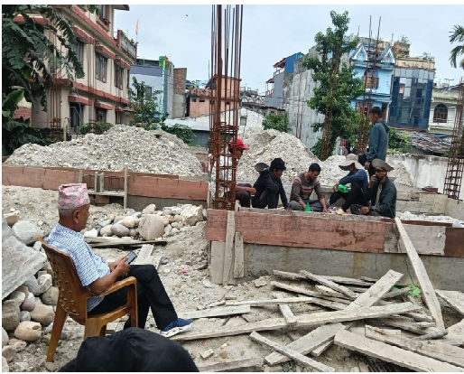
दमक नगरप्रमुख रामकुमार थापाको निजी निवास भवन २३ र २४ को आन्वेलनका क्रममा आगजनी भएपछि भग्नावशेष पसिणत भएपछि राष्ट्रिय प्रजातन्त्र पार्टी सम्बद्ध व्यक्तिकहरूको सहयोगमा उक्त निवासको पुनर्निर्माण भईरहेको बेला हेरचाह गर्दै थापा ।
