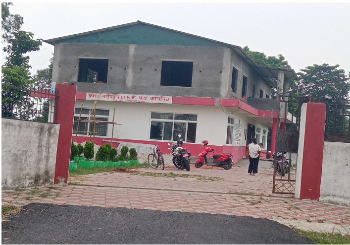
कमल गाउँपालिका वडा नं. ४ को वडा कार्यालय भवन पुननिर्माण हुँदै ।
